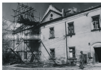
Objekt tzv. Josífky byl vystavěn v roce 1868 na místě starší barokní budovy. Na snímku z roku 1987 je zachycena probíhající rekonstrukce, po níž se sem nastěhovala odborná pracoviště Okresního muzea.
