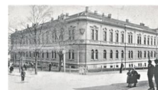
Než přejdeme křižovatku do Huťské ulice, prohlédněme si ještě budovu tehdejšího hejtmanství (29). Budova sloužila původně jako četnická kasárna a po vzniku C. K. okresního hejtmanství na Kladně v roce 1893 zde sídlil i okresní hejtmán. Všimněte si, že na snímku ještě není dostavěná zadní nárožní část a také se změnil znak na nároží budovy. Pohlednice z přelomu 19. a 20. století.
