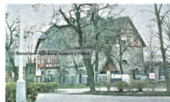
Na protější straně ulice stojí od roku 1905 vila (35) původně určená vyšším úředníkům Pražské železářské společnosti . V každém podlaží byl samostatný byt a v suterénu byt domovníka. Je s podivem, že si budova po více než sto let zachovala svůj původní ráz. Tedy až na oplechované arkýře na střeše. Za socialismu vila sloužila jako Dům politické výchovy. Foto z knihy 100 let oceli Poldi . Praha: Práce, 1989.
