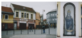
Proluka vzniklá po zboření rohového domu byla zastavěna v roce 2001. V té době ještě fasádu domu čp. 9 zdobil výklenek se sochou Panny Marie.
