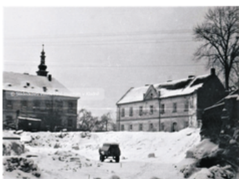
Terénní úpravy při zahloubení silnice.
