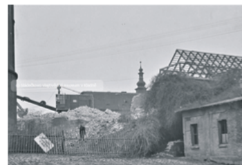
Garáže byly zbořeny v 50. letech 20. století, když zde byla budována nová část ulice Dělnického hnutí (dnes Zádušní). Vlevo apsida kostela, v pozadí zámek.
